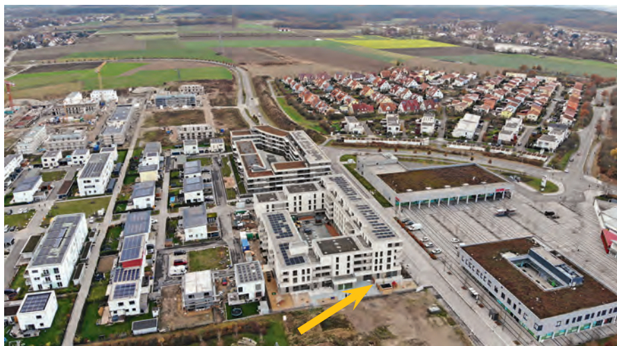
KiTa Goeschelstraße (siehe Pfeil) im Büchenbacher Westen
